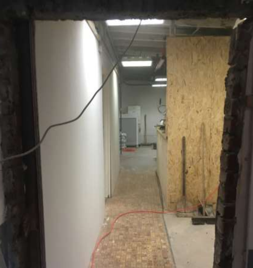
Blick in den Flur mit neuer Wand links... Zukünftige Toilette rechts
