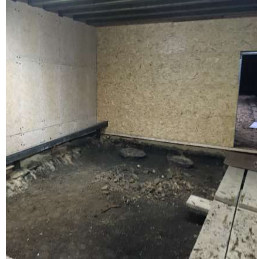
Aushub Kurzaffenstand für Betonfundament /Bauwand
