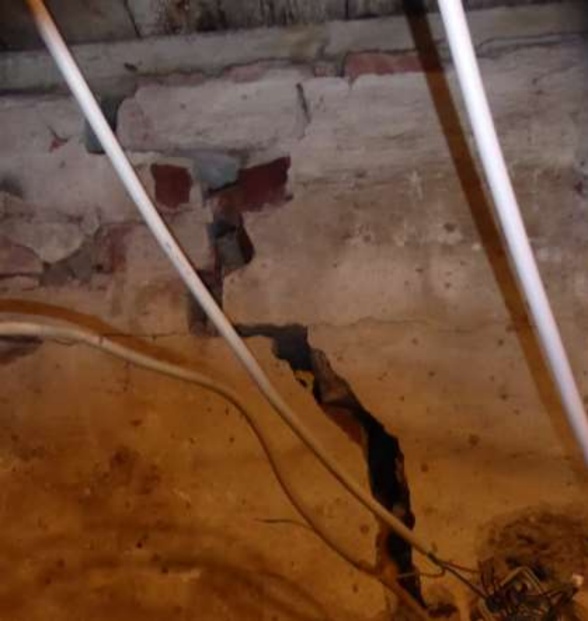
Risse im Mauerwerk im Eingangsbereich sowie im Flur
