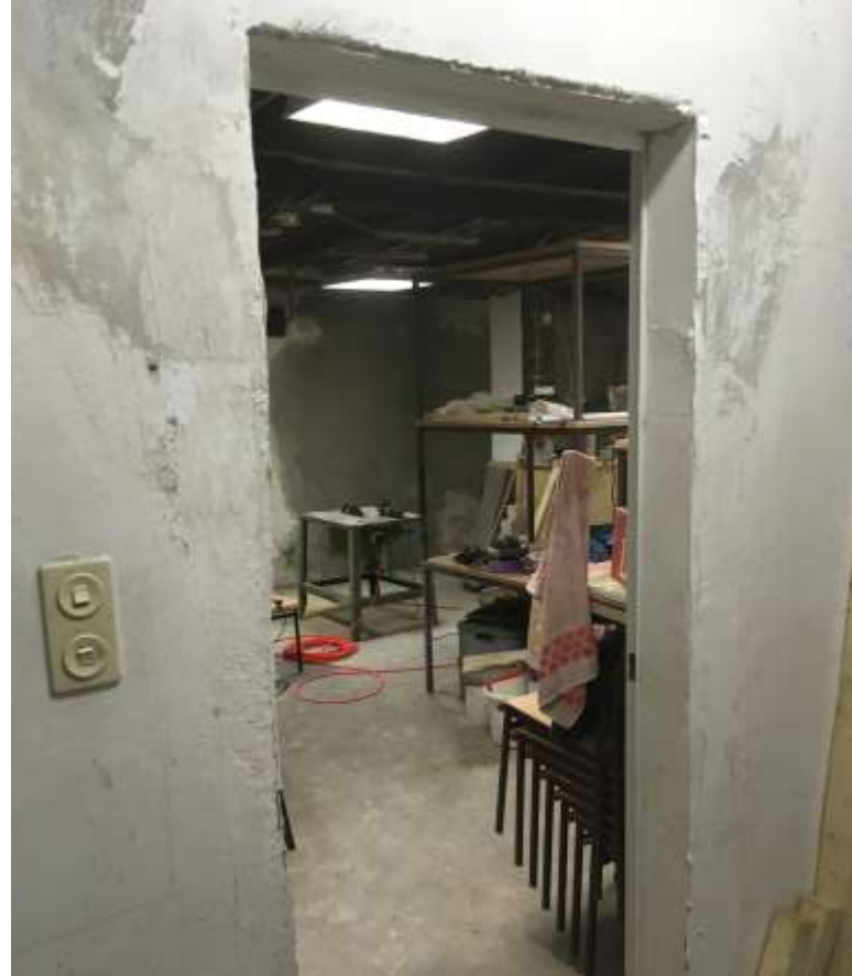
Neuer Durchgang zum Kurzaffenstand
