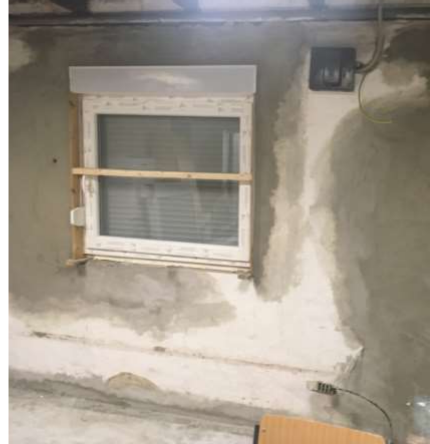
Neue Fenster rein!
